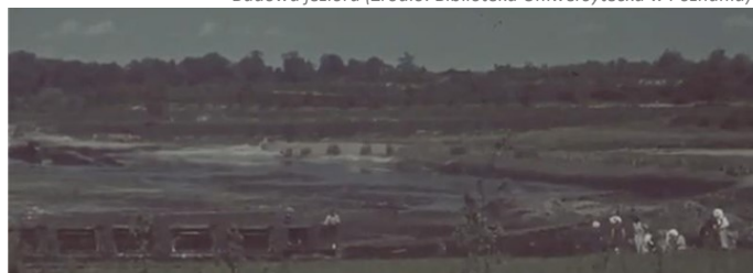
Budowa jeziora (Źródło: Biblioteka Uniwersytecka w Poznaniu)
