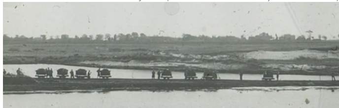
Budowa jeziora (Źródło: Biblioteka Uniwersytecka w Poznaniu)
